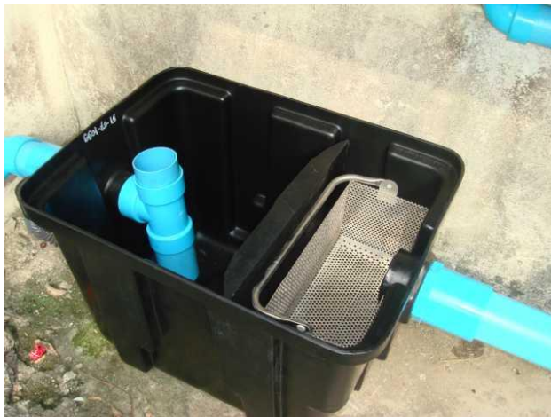
ภาพที่ 6-15 รูปแบบทั่วไปของบอดักไขมันสำเร็จรูป
