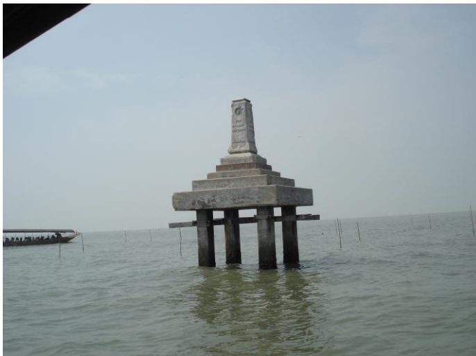
ภาพที่ 1-2 หลักเขตของ กรุงเทพมหานคร หลักเขตที่ 28 เมื่อสมัยก่อนอยู่บนบก แต่ปัจจุบันหลักเขตดังกล่าว อยู่กลางทะเลห่างจาก ชายฝั่งประมาณ 300-400 เมตร หลักเขตที่ 29 ก็ เช่นเดียวกันอยู่ห่างจาก หลักเขตดังกล่าวประมาณ 800 เมตร
